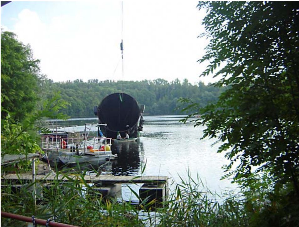
Rückbau der Standenclosure im Phenolsee "Vollert Süd". Einer der Enclosure, in dem Pilotversuche stattfanden, wird an einem Kran aus dem See gezogen. Ort: Trebnitz/Sachsen-Anhalt
