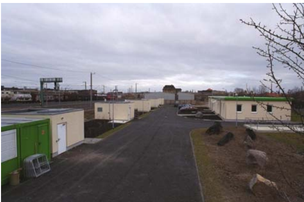
Safira- Pilotanlage zur Grundwassersanierung in der Region Bitterfeld mit links den fünf Brunnenhäusern und rechts dem Laborgebäude
